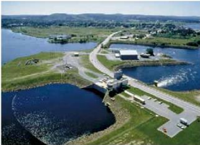
FIGURA 23.18. A. Diagrama simplificado que muestra el principio de la presa mareal. La electricidad se genera solo cuando hay una diferencia agua-altura suficiente entre la bahía y el océano. B. Planta de energía mareal en Annapolis Royal, Nueva Escocia, en la Bahía de Fundy (Foto de James P. Blair/National Geographic Image Collection).
