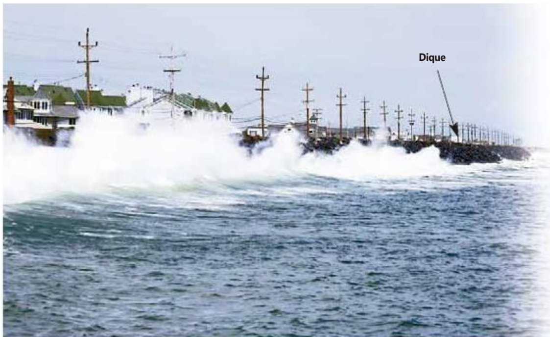
FIGURA 20.22. Seabright, en el norte de Nueva Jersey, contaba con una amplia playa arenosa. Se construyó un dique de unos 5 a 6 m de altura y 8 km de largo para proteger la ciudad y los raíles del tren que traían a los turistas a la playa. Como puede observarse, tras construir el dique la playa se estrechó de forma extraordinaria (Foto por Rafael Macia/Photo Researchers, Inc.).
