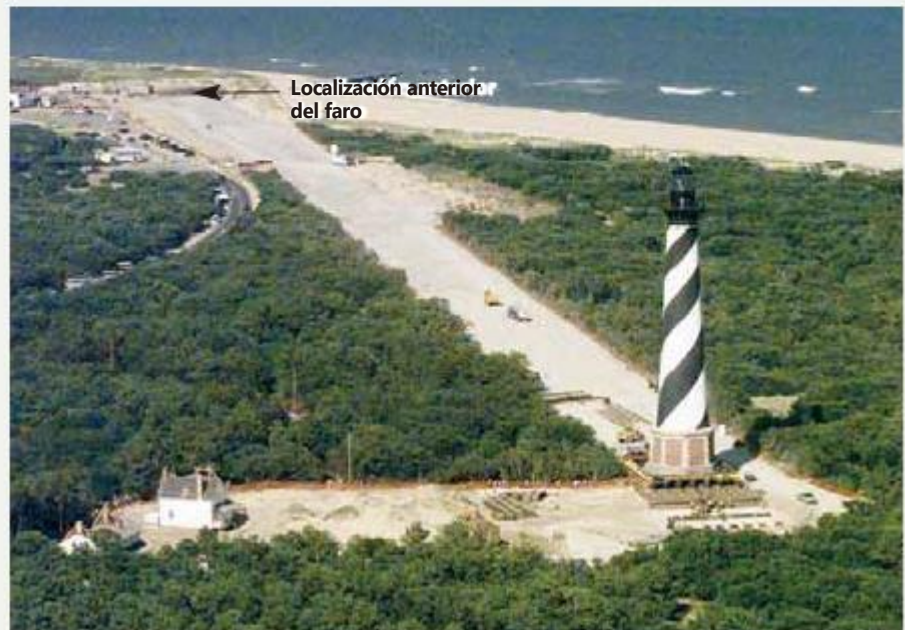
FIGURA 20.B. El faro del cabo Hatteras después de haber sido trasladado 884 m desde la línea litoral. En su nuevo emplazamiento debería estar seguro unos 50 años o más (Foto cortesía de Drew Wilson, Virginian-Pilot , copyright 1999).
