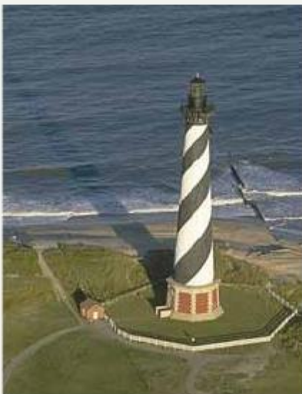
FIGURA 20.A. Cuando el faro del cabo Hatteras de Carolina del Norte fue amenazado por la erosión de la línea de costa en 1999, fue trasladado a 488 m de la línea de costa (Foto de Don Smetzer/PhotoEdit Inc.).
