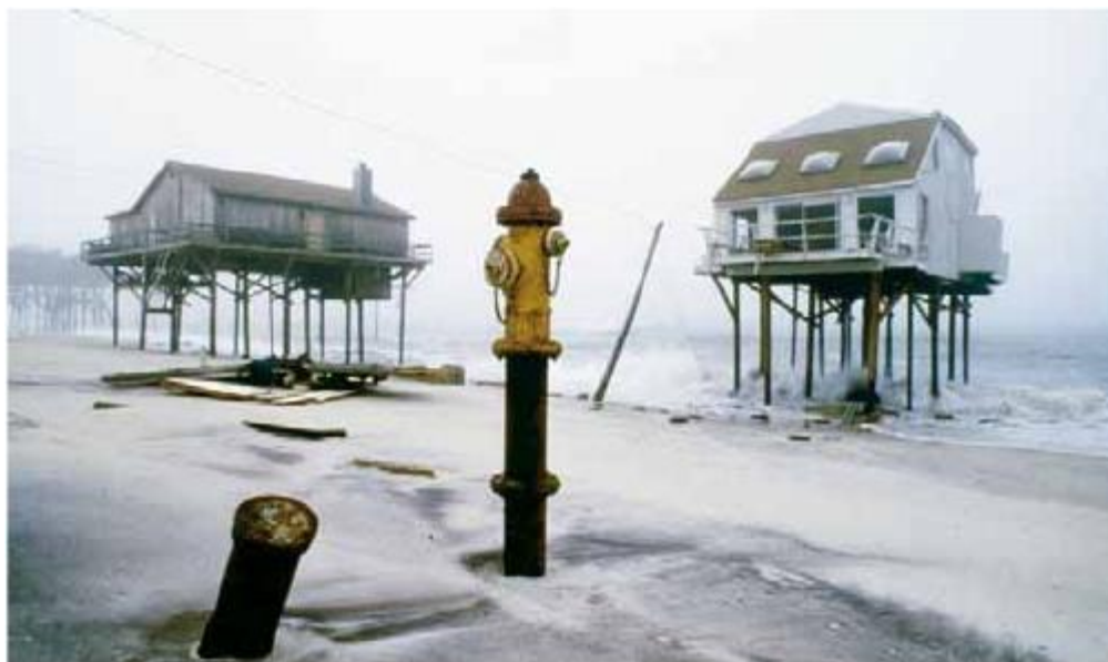
FIGURA 20.18. La erosión de las olas causada por las tormentas obligó a abandonar esta línea litoral muy edificada en Long Island, Nueva York. Las zonas costeras son lugares dinámicos que pueden cambiar rápidamente en respuesta a las fuerzas de la naturaleza (Foto de Mark Wexler/Woodfin Camp Associates).
