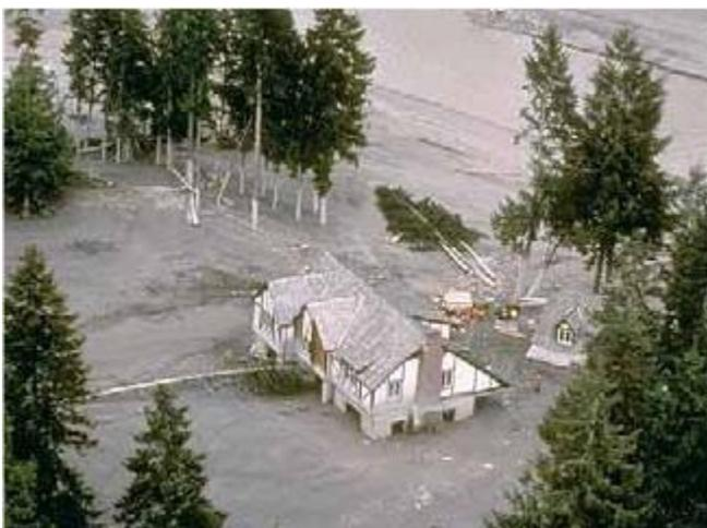
**FIGURA 15.19.** Casa dañada por un lahar a lo largo del río Toulte, al oeste-noroeste del monte Santa Elena. La sección final de la casa fue desgajada e incrustada contra los árboles (Foto de D. R. Crandell, U. S. Geological Survey).
