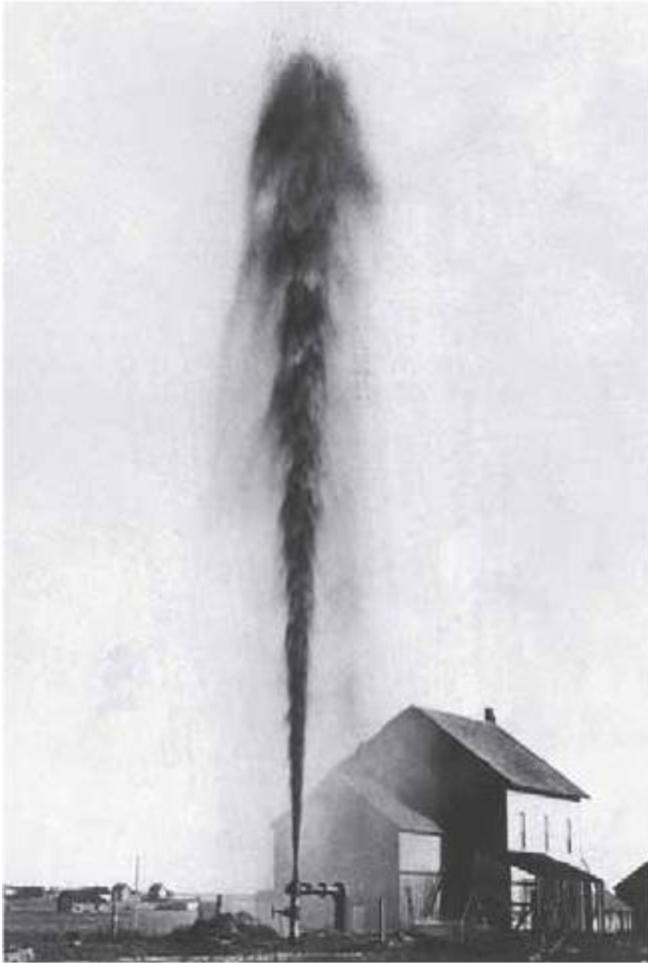
**FIGURA 17.20.** Pozo artesiano que fluye «en forma de surtidor» en Dakota del Sur a principios del siglo xx. El vapor de agua de una tubería de unos 7,6 cm alcanzó una altura de unos 27 m. En la actualidad se explota el mismo acuífero limitado a través de millares de pozos adicionales; por tanto, la presión ha descendido hasta el punto de que muchos pozos han dejado de fluir por completo y deben bombearse (Foto de N. H. Darton, U. S. Geological Survey).
