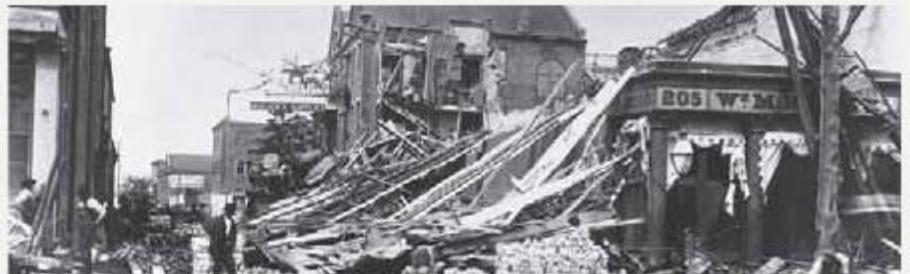
**FIGURA 11.C.** Daños en Charleston, al sur de Carolina, causados por el terremoto que tuvo lugar el 31 de agosto de 1886. El daño osciló entre la caída de chimeneas y la ruptura de paredes hasta el hundimiento total (Foto cortesía de U. S. Geological Survey).
