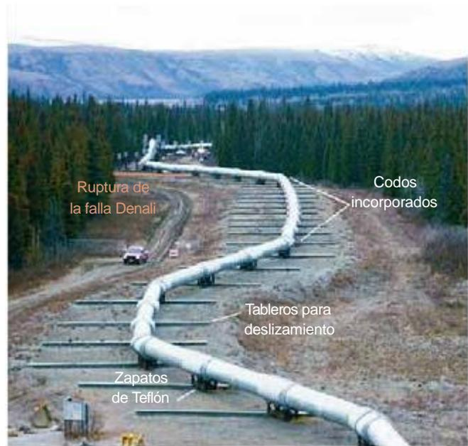
**FIGURA 11.30.** El oleoducto que atraviesa Alaska se diseñó y construyó para resistir varios metros de desplazamiento horizontal donde atraviesa la falla Denali. Durante un terremoto de magnitud 7,9 en 2002, el oleoducto se movió tal como estaba previsto y no se produjo derrame de petróleo. Esto ilustra la importancia de estimar un posible movimiento del terreno y diseñar estructuras para mitigar los riesgos. (Foto por cortesía de USGS).
