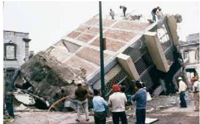
**FIGURA 11.23.** Efectos de la licuefacción. Este edificio inclinado reposa sobre sedimento no consolidado que se comporta como arenas movedizas durante el terremoto mexicano de 1985 (Foto de James L. Beck).
