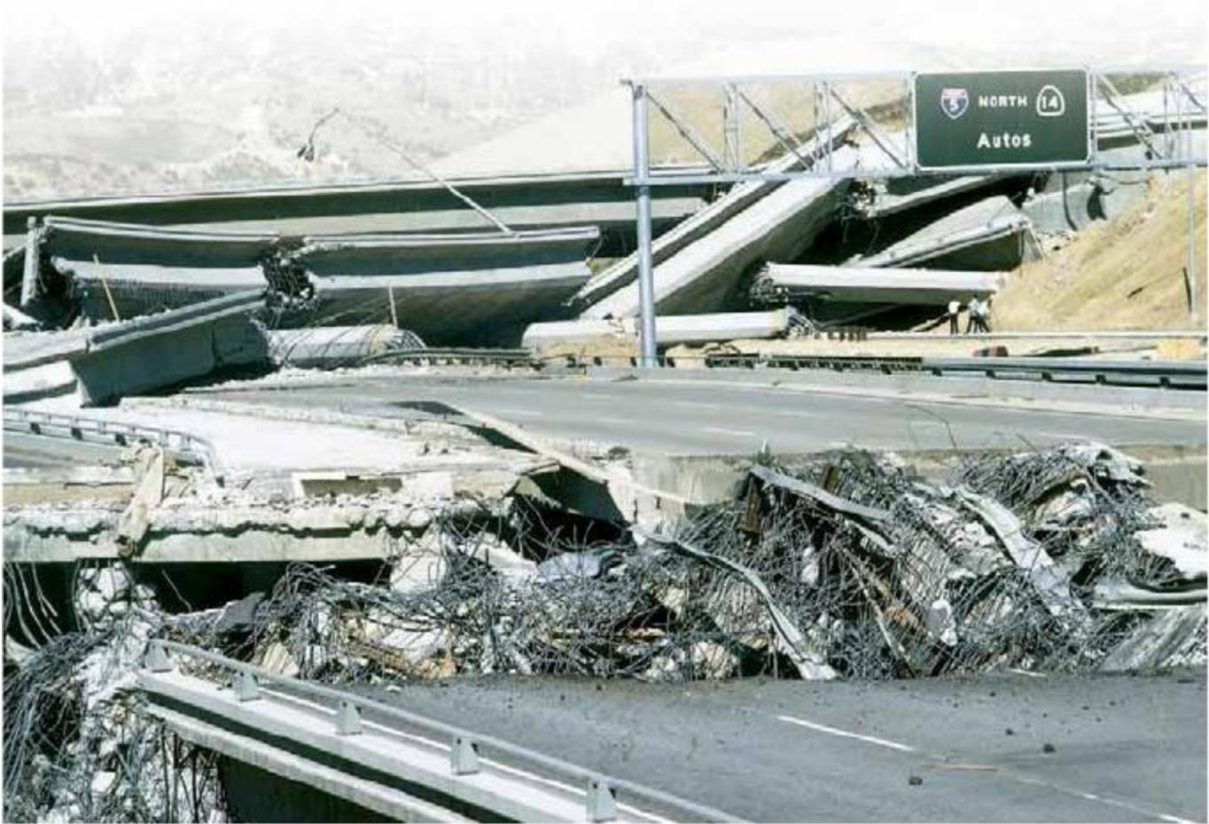
**FIGURA 11.29.** Daño a la Interestatal 5 causado por el terremoto del 17 de enero de 1994 en Northridge (Foto de Tom HcHufh/Photo Researchers, Inc.).
