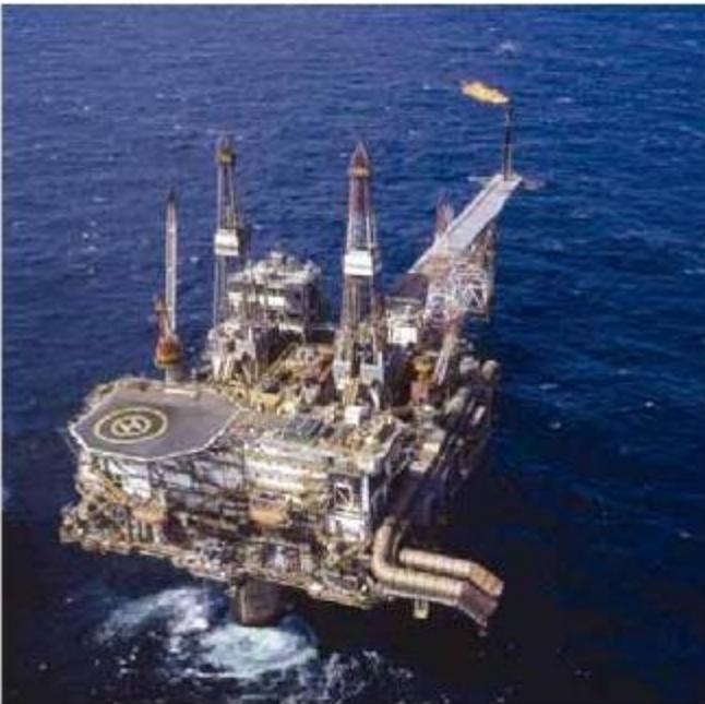
**FIGURA 13.8.** Torres de perforación alejadas de la costa que se emplean para explotar las reservas de petróleo o gas natural de la plataforma continental. Esta plataforma se encuentra en el Mar del Norte (Foto por Peter Bowater/ Photo Researchers Inc.).
