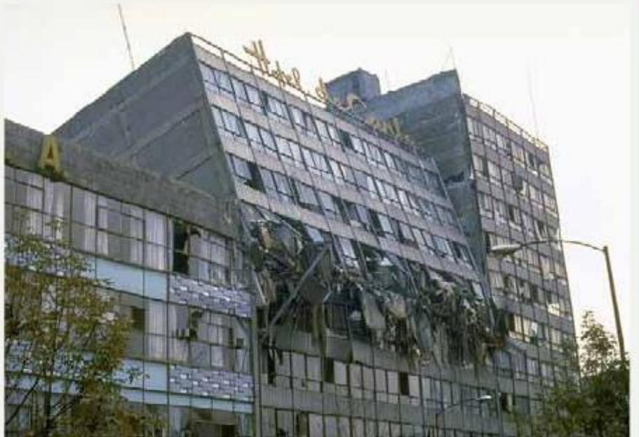
**FIGURA 11.A.** Durante el terremoto mexicano de 1985, los edificios de apartamentos se balancearon hacia adelante y hacia atrás hasta 1 m. Muchos, entre ellos el hotel mostrado aquí, se hundieron o resultaron gravemente dañados (Foto de L. Beck).
