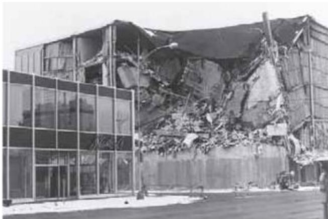
**FIGURA 11.22.** Daños causados al edificio de cinco plantas J. C. Penney Co., Anchorage, Alaska. El edificio adyacente sufrió muy pocos daños estructurales (Foto cortesía de NOAA/Seattle).
