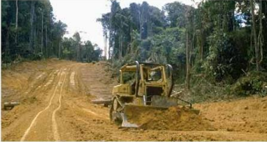
FIGURA 6.E. Desbroce de la selva tropical en el oeste de Kalimantan (Borneo), Indonesia. El grueso suelo laterítico está muy lixiviado (Foto de Wayne Lawler/Photo Researchers, Inc.).
