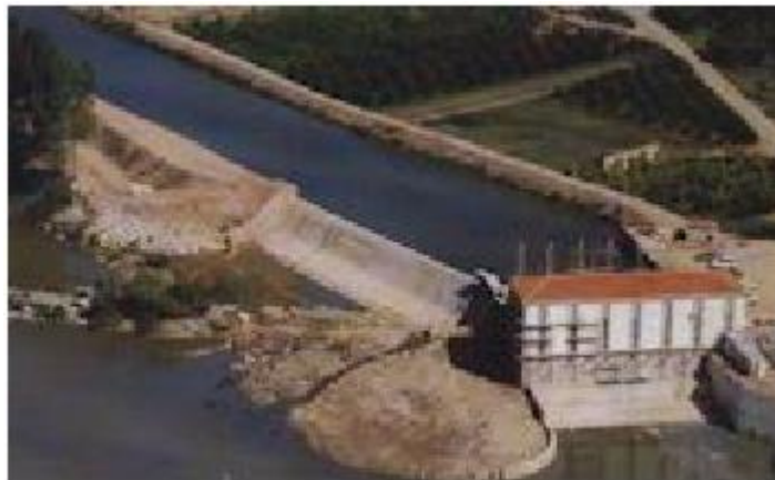
Fig. 10.19 Minicentral hidroeléctrica fluyente
