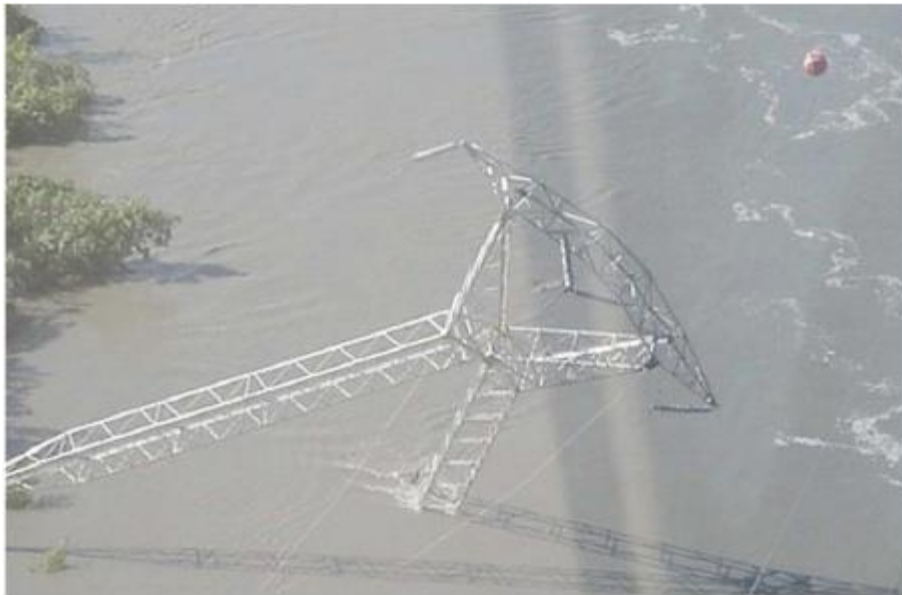
Figura 15.2 Volcamiento de una torre de transmisión. (Cortesía de Theofilos Toulkeridis)
