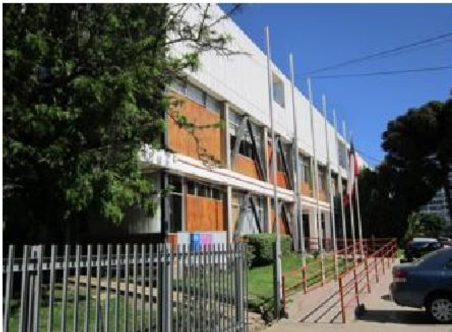
Figura 15.25 Estructura reforzada en Viña del Mar, con diagonales de acero.
