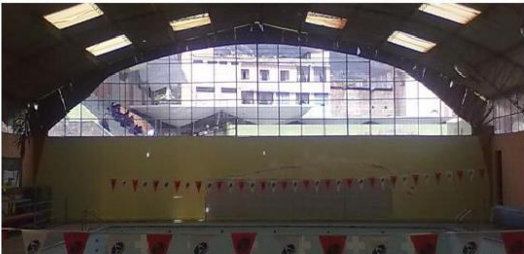
Figura 15.7 Vista interior de la Piscina del Colegio Fernández Madrid de Quito. Sin reforzamiento.
