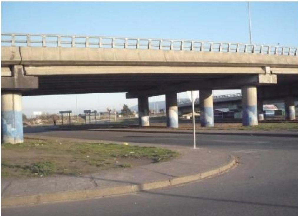
Figura 1.2 Tramo del Puente Llacolén, ubicado en Concepción, Chile.
