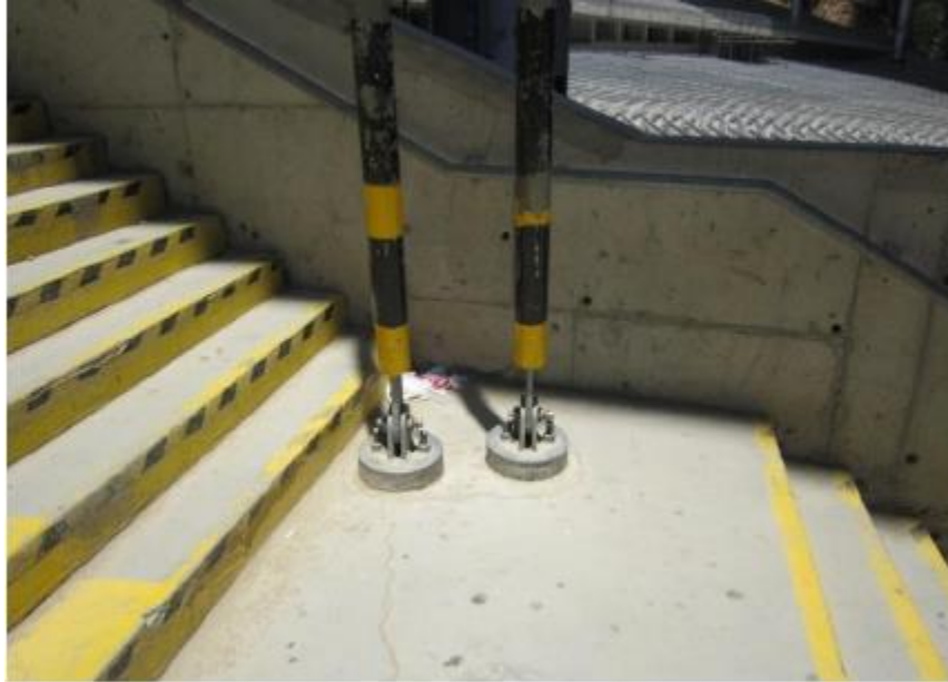
Figura 2.33 Articulación fija de una estructura de acero.
